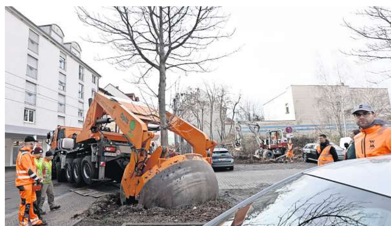
Eine Spezialmaschine gräbt am Parkplatz der Sparkasse in der Gorkistraße eine 28 Jahre alte Rosskastanie aus und bringt sie an einen neuen Platz. Sie steht den Bauarbeiten im Wege und hat aufgrund der ausgedehnten Flächenversiegelung auch keine optimalen Standortbedingungen. FOTO: ANDRÉ KEMPNER
